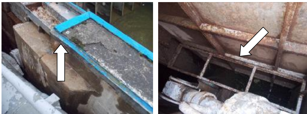
Poškození koruny plata a lávky v šachtě
